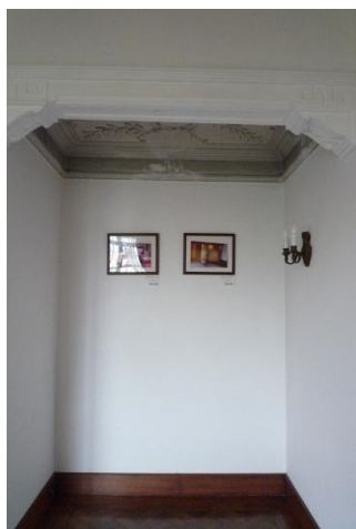
2階の洋室、漆喰の仕切り飾り
